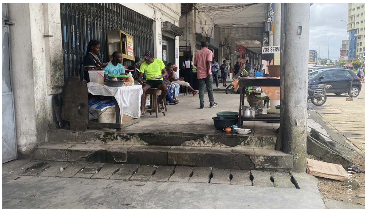
Image 25 : Discontinuité d'une galerie piétonne à Douala.
