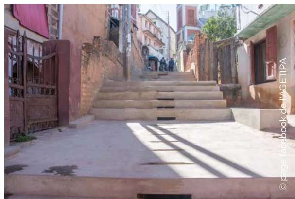
Image 34 : Aménagement d'un escalier.
